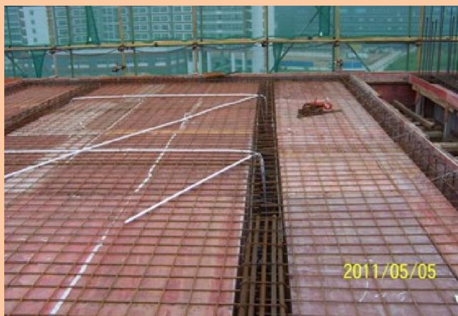
底网与管线安装完
