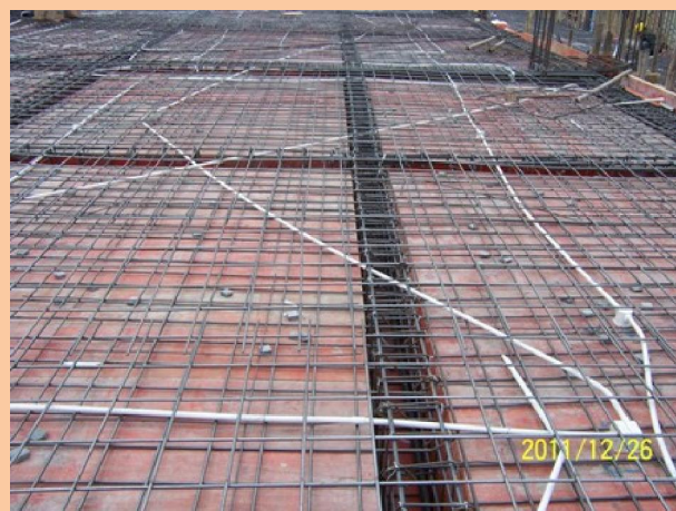
底、面网安装完
